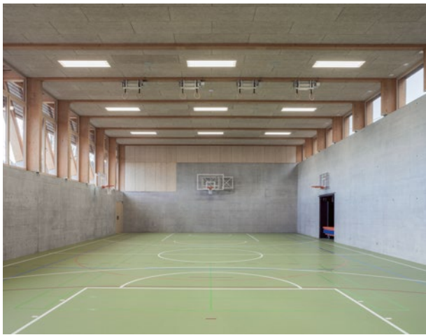
2 Das Hängetragwerk im oberen Geschoss überspannt die Turnhalle.
