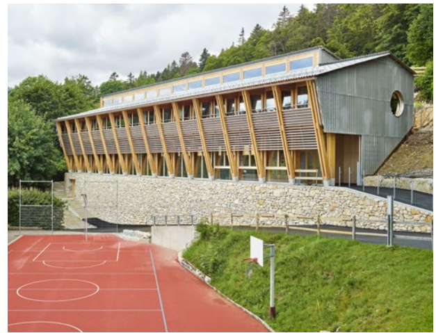
3 Die Hanglage ermöglicht eine problemlose Gestaltung aller Zugänge.
